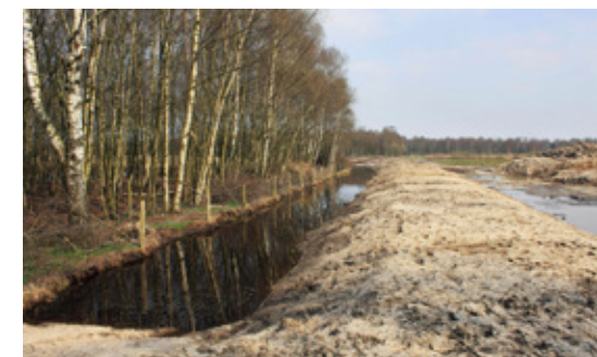
Dammenbouw centraal in de Engbertsdijksvenen in september 2008. Foto: Gerrit Schepers
